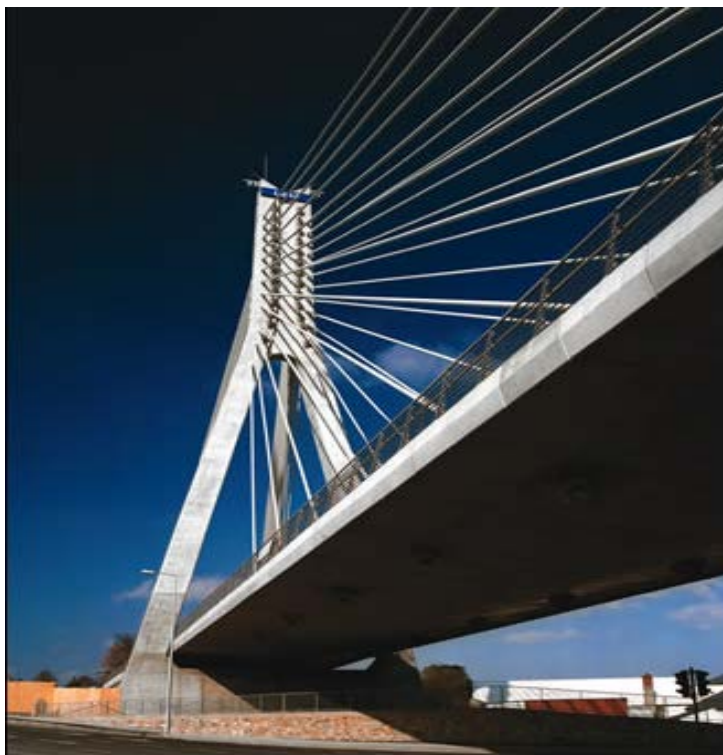
Мост Луас, изготовленный из шлакощелочного бетона (Дандрум, Ирландия)
